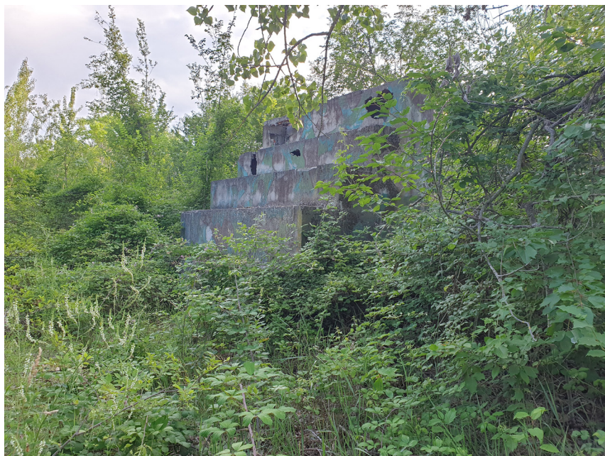
Figura 21 - Costruzione per addestramenti militari, giugno 2020.
